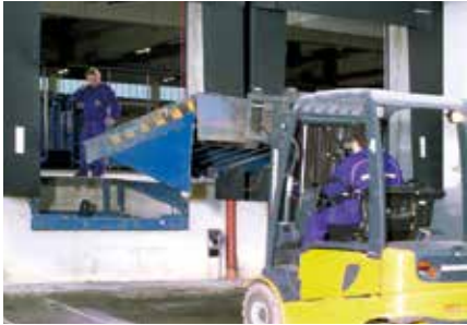
Demontirajte stari utovarni most, eventualno prilagodite rov (npr. montažnim pločama ili konzolama)
