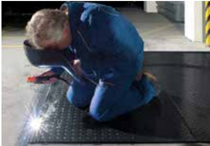
Zavarite na ugaone ivične profile – i gotovo!
