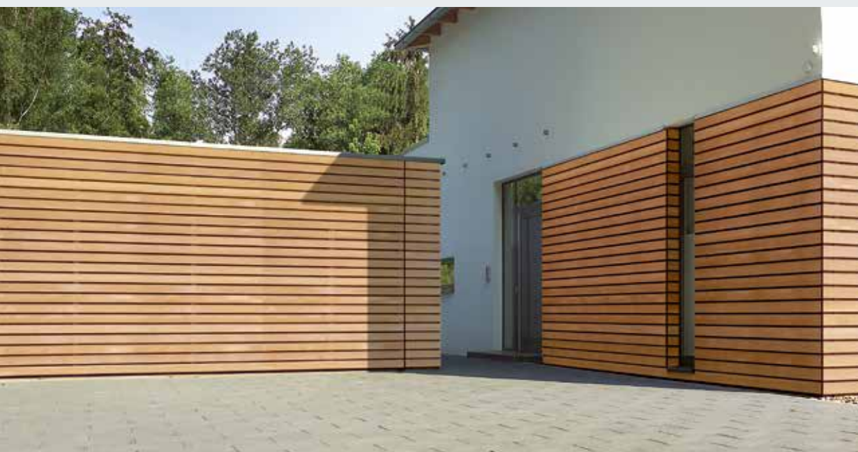
Oblaganje na mestu ugradnje sa drvenim panelima
